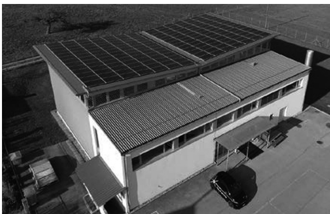
Bild: PV-Anlage Brünisried
